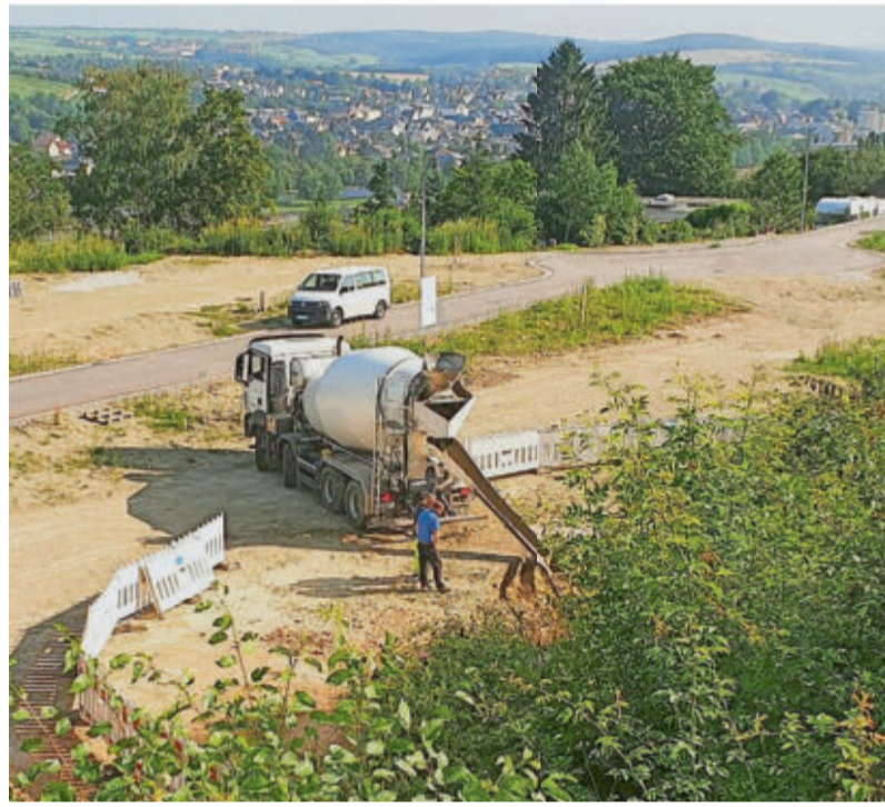
Das Loch wurde mit Beton gefüllt.
